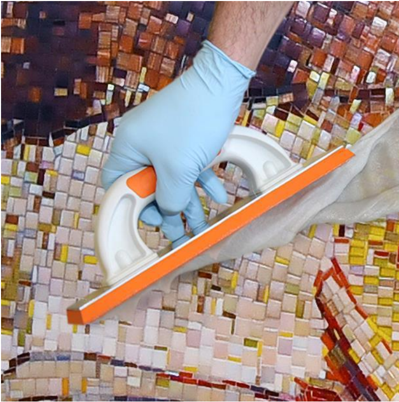
Verfugung mit PCI Durapox Premium Harmony ( Link zum hochauflösenden Photo )
