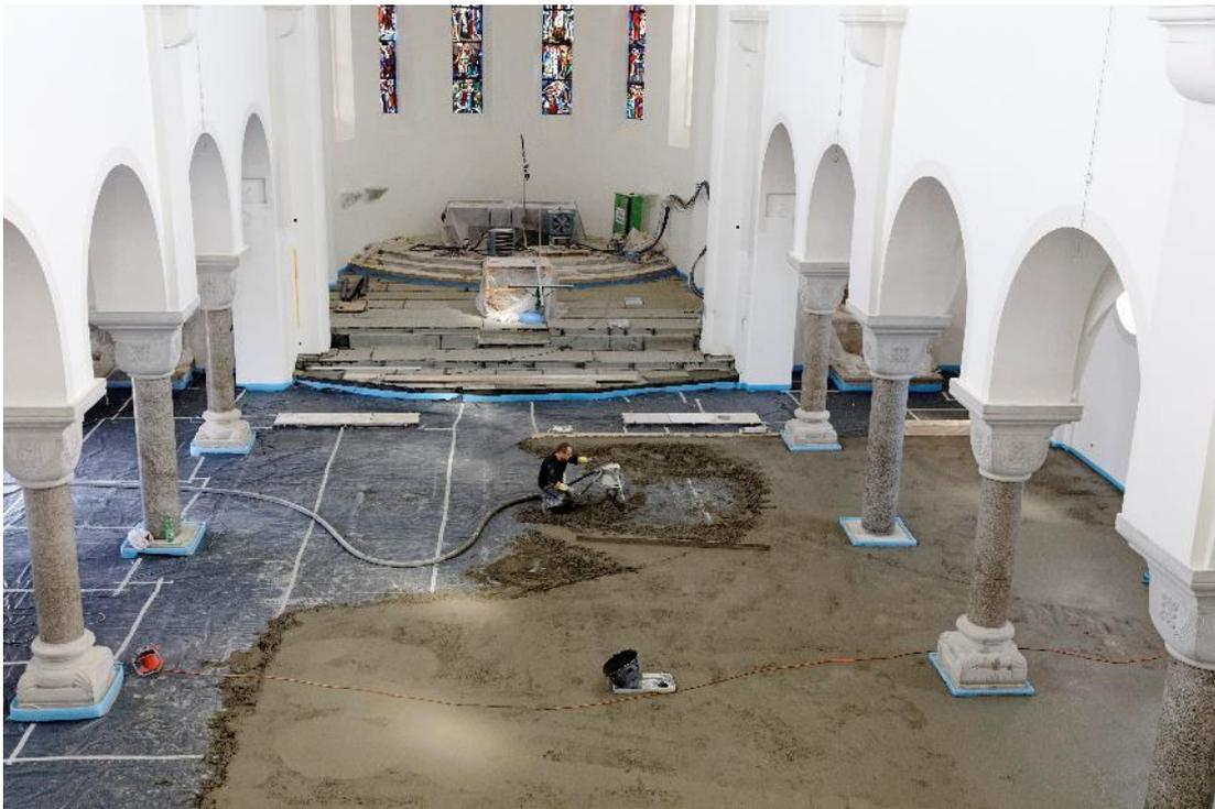
PCI-Systemlösung Estrichsanierung: Handwerker profitieren von extrem kurzen Trocknungszeiten und schneller Belegreife. ([Link](#) zum hochauflösenden Photo)
