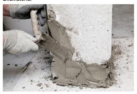
PCI-System für Betonreparatur mit statischem Anspruch (z.B. Säulen, Balkone und Treppen) (©PCI Augsburg GmbH, Link zum hochauflösenden Photo).
