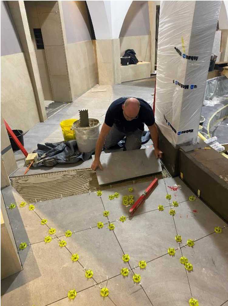
Im Ruhebereich verlegten die Handwerker die großformatigen Platten mit dem verformungsfähigen Fliesenkleber PCI Flexmörtel S1 Flott, der das Einsinken der schweren Megaformate verhindert. ( Link zum hochauflösenden Photo, ©PCI Augsburg GmbH)
