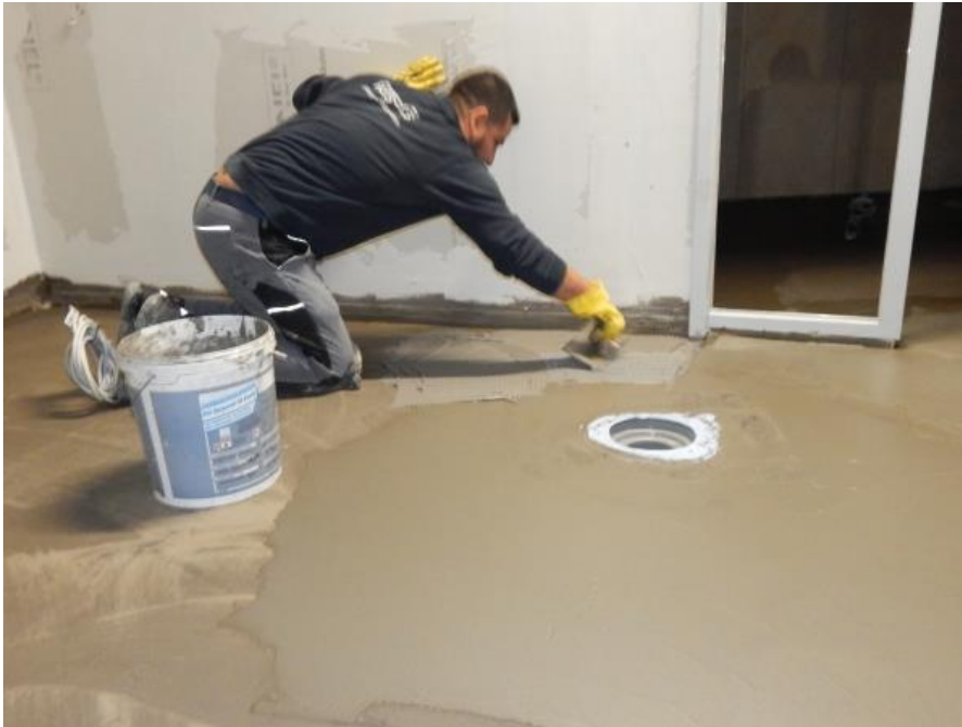
Am zentralen Ruhepool des Orientalischen Bads verwendeten die Fliesenleger PCI Seccoral 2K Rapid. ( Link zum hochauflösenden Photo, ©PCI Augsburg GmbH)
